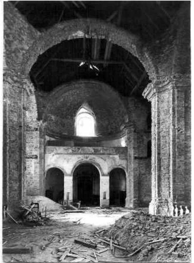
Widok w kierunku ołtarza i wejścia głównego po zawaleniu się sklepienia w 1957 r. Fotografia stanu z 1961 r.
