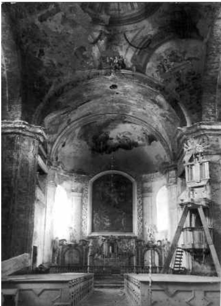
Zustand des Inneren um 1955.
